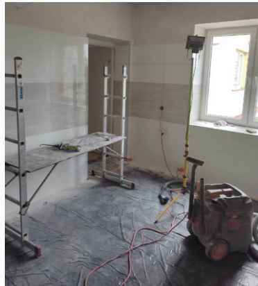
w trakcie realizacji
